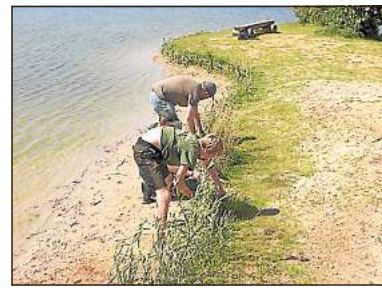
Das Einpflanzen von Weiden oder Schilfrohr dient der Uferbefestigung. Die künstlich angelegten Landzungen sind Spitzenplätze für die Angler.
